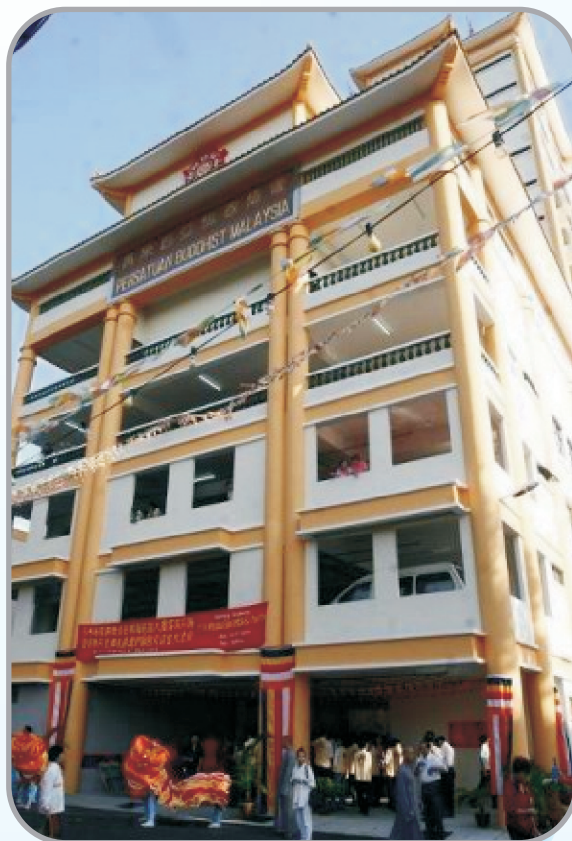
马佛总新大厦外观
